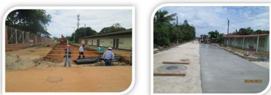
Obras de construcción segunda etapa pavimentación casco urbano de municipio de Orocué
