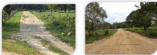
Obras de mejoramiento de la vía Palestina - Palmarito - Patos Gandul San Luis de Palenque.
