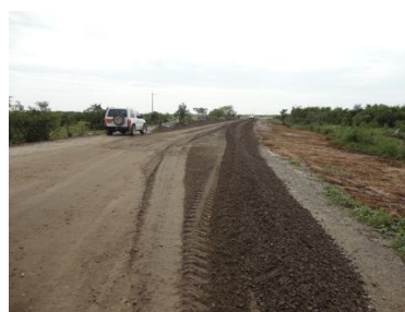
Pavimentación vía Yopal - El Algarrobo - Orocué sector la Turupa - Quebrada Seca.
