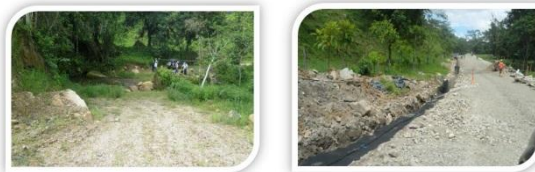
Obras de Pavimento de la vía San Benito-Recetor Chámeza
