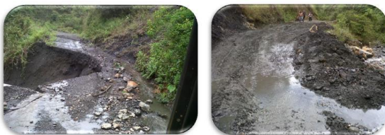
Vía casco urbano – Rodrigoque, tipo de intervención: remoción de derrumbe
