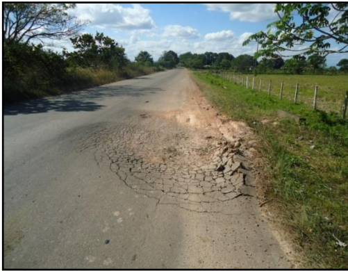
Foto 5. Fallos asociados a Falla de terraplén por deficiencia en el atraque en sectores adyacentes a obras de drenaje. En el caso en que éstos ocupen un longitud mayor de 3 metros y presente hundimientos importantes se denominan fallos combinados.
