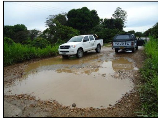
Foto 5. Fallos asociados a Falla de terraplén por deficiencia en el atraque en sectores adyacentes a obras de drenaje. En el caso en que éstos ocupen un longitud mayor de 3 metros y presente hundimientos importantes se denominan fallos combinados.
