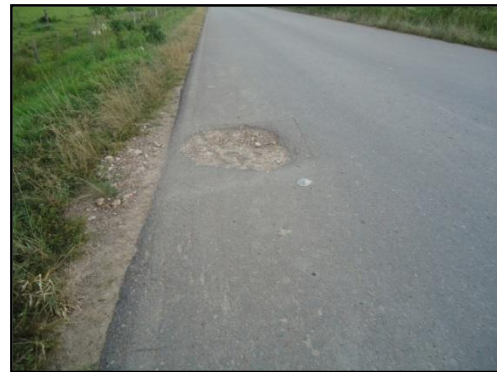
Foto 4. Fallos asociados a falla estructural por fuga de combustible y no reparación de zonas de muestras.
