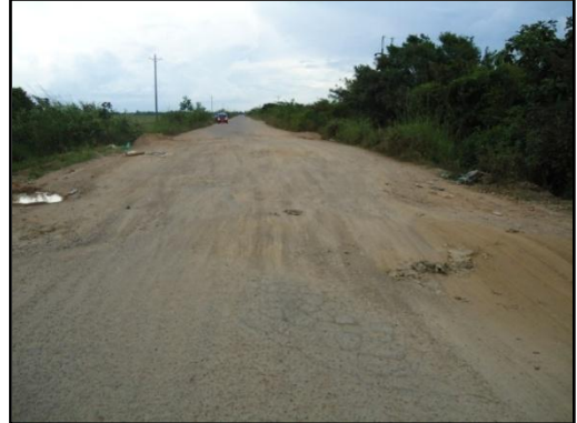
Foto 6. Fallos combinados: Falla por capacidad portante y Falla de Terraplén por deficiencia en el atraque
