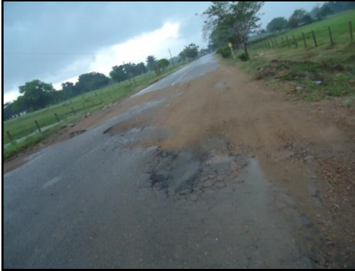
Foto 6. Fallos combinados: Falla por capacidad portante y Falla de Terraplén por deficiencia en el atraque
