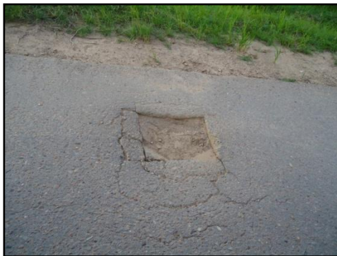
Foto 4. Fallos asociados a falla estructural por fuga de combustible y no reparación de zonas de muestras.
